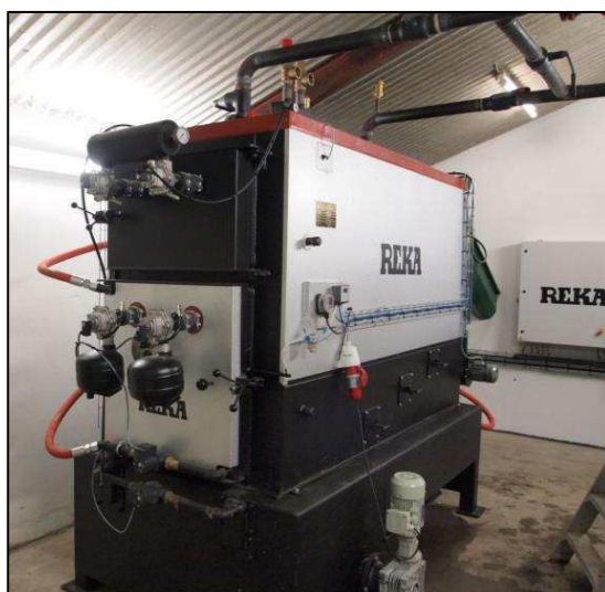
Figure 13 : Modèle chaudière biomasse – 400 kW
